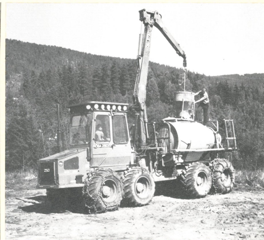
ÖSA 250 med påmonterad cementtrumma och betongtratt.
