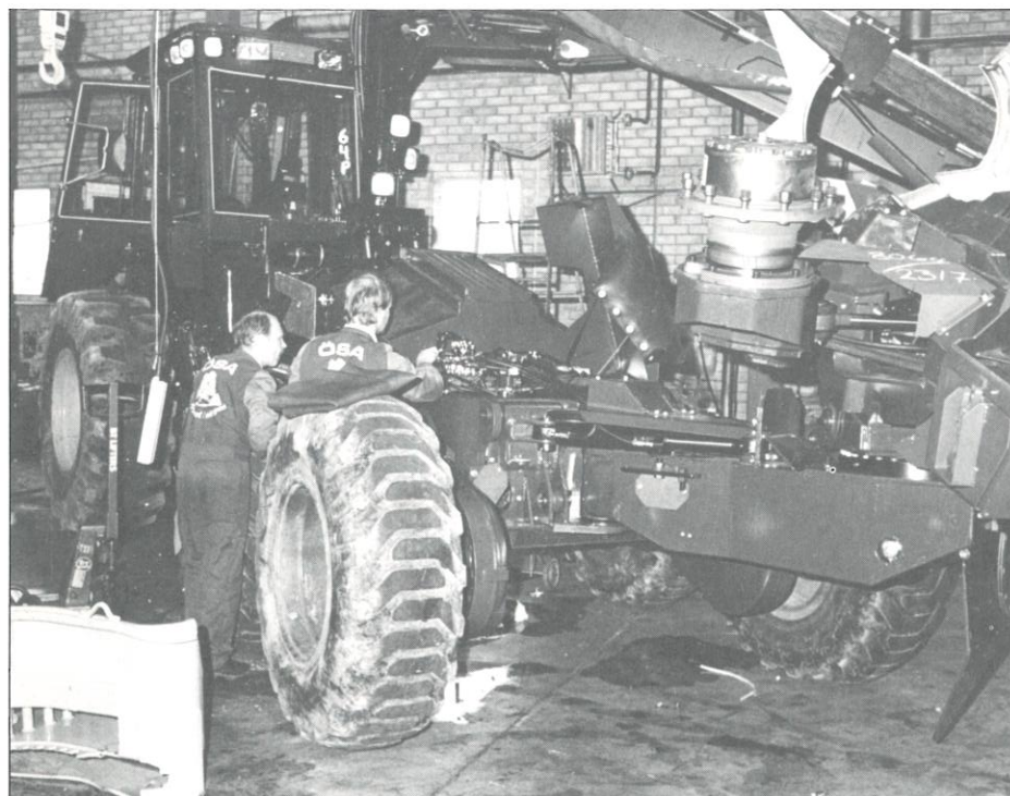
Slutavsyning utförs på samtliga produkter för att förhindra att produkter med felaktigheter går ut till kund. Jan-Olov Eriksson och Göran Backåker (t v) diskuterar här kvalitet på en 280 skördare.
