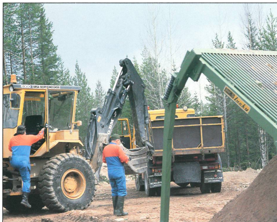
Underhållet av vägarna har varit en stor uppgift för Besparingsskogen.
